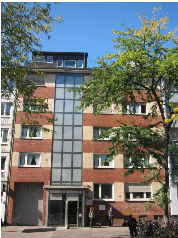
Foto 2: Außenansicht Haus der Wohnungslosenhilfe
