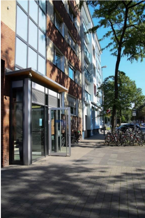
Foto 3: Außenansicht Haus der Wohnungslosenhilfe
